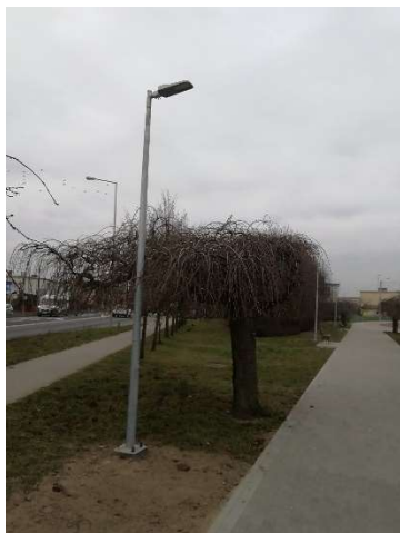
Ul.Zachodnia-oprawa LED -BGP
