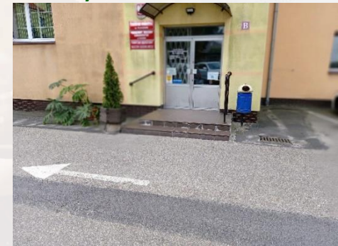
Fot. 28. Schody do budynku B Starostwa Powiatowego
